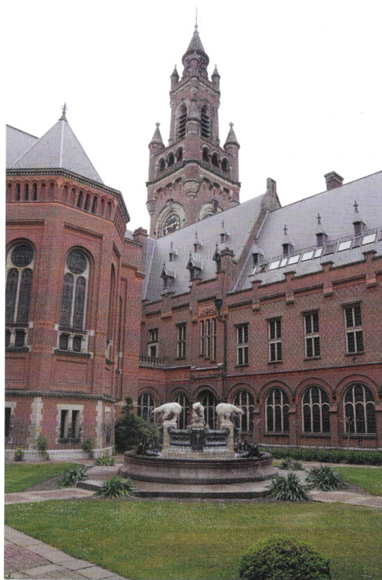
1) Binnenplaats van het Vredespaleis gezien naar het zuidoosten met op de voorgrond de Ijsberenfontein voor de aanvoer van de lucht en achter de toren voor de afvoer van de lucht. (foto RS)
